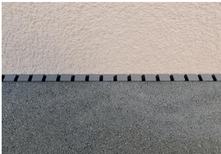
Gesicherter Feuchtigkeitstransfer entlang der Fassade.
