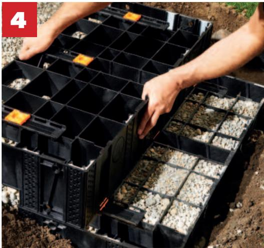
4 Die erste Stufe ausrichten, 1% Gefälle nach vorne wegen Wasserablauf.
