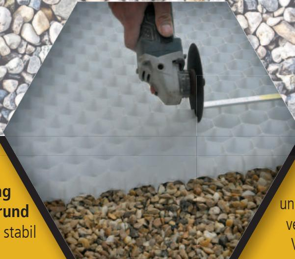
Je nach Bedarf **Einfassung aufbauen** und den **Untergrund so vorbereiten**, dass er sehr stabil und gut verdichtet ist.
