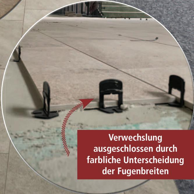
Verwechslung ausgeschlossen durch farbliche Unterscheidung der Fugenbreiten
