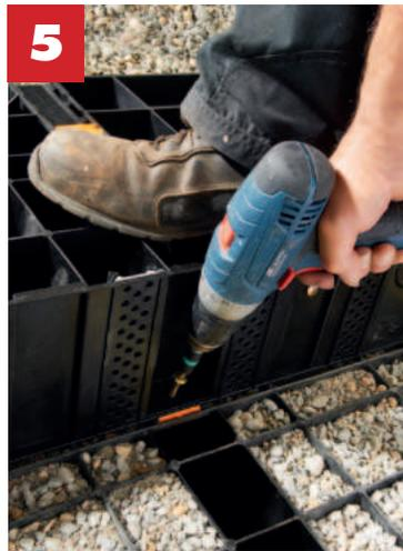
5 Die weiteren Stufen in die Schienen schieben, bis die gewünschte Höhe erreicht ist.
