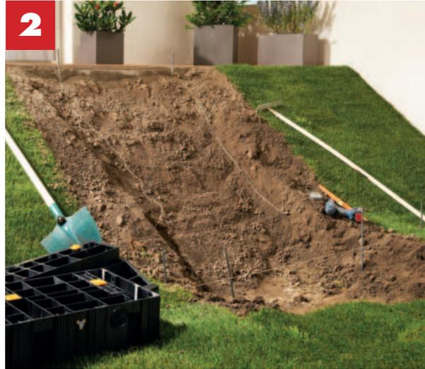
2 Vorbereitung des Grundstücks: Den Boden aufgraben und die Oberfläche ebenen.
